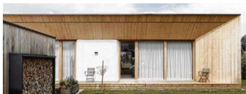
Statt konventioneller Baustoffe verwendete Architekt Georg Bechter bei diesem Gebäude Stroh, verputzt wurde es mit einem Lehmputz. BILD: BECHTER
